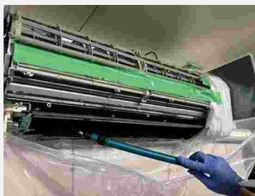
エアコンクリーニング
